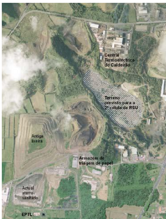
Figura 4 – Delimitação da área prevista para a nova célula da ETRSU (Cenário alternativo à construção do ECOPARQUE).
